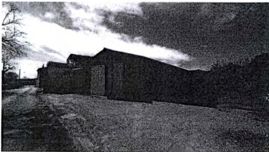
PIGNON EST ET FAÇADE NORD DU BÂTIMENT
