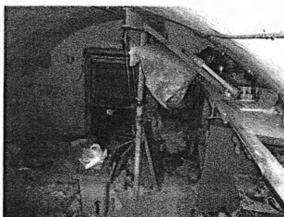
ACCES AUX 3 CAVES VUE DE LA 1RE CAVE
