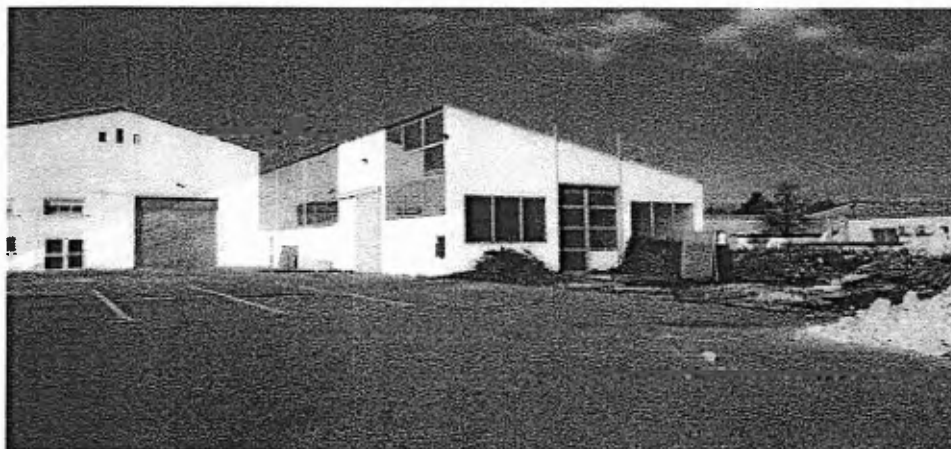
FAÇADES SUD ET OUEST DU BÂTIMENT
