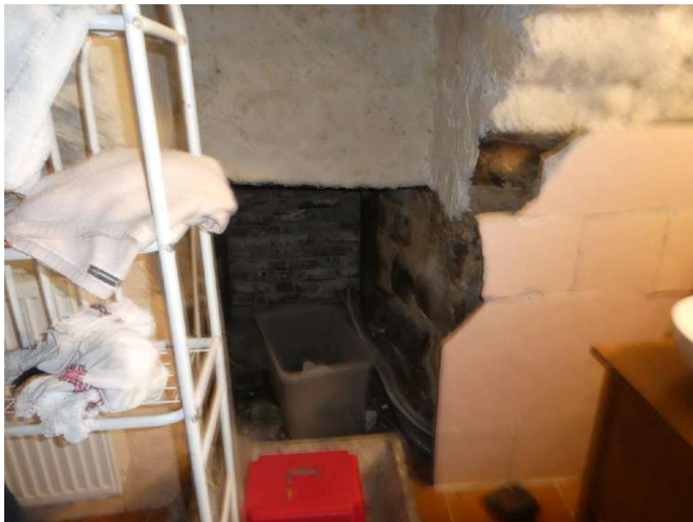
Salle de bain (avec ouverture dans le mur)
