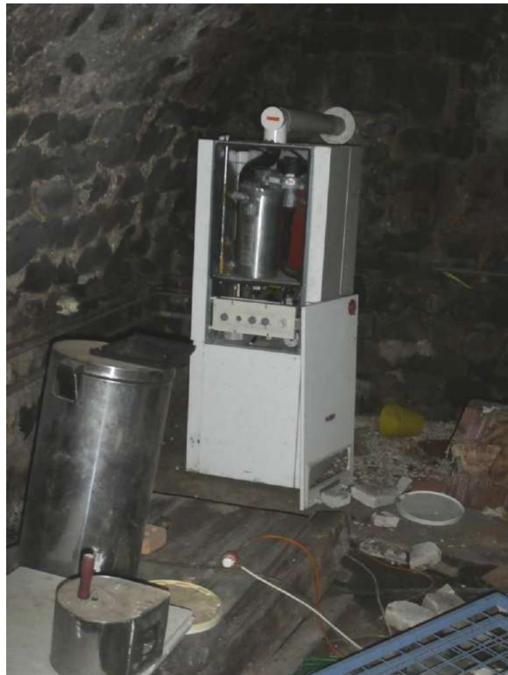
Chaudière (dans la chaufferie)
