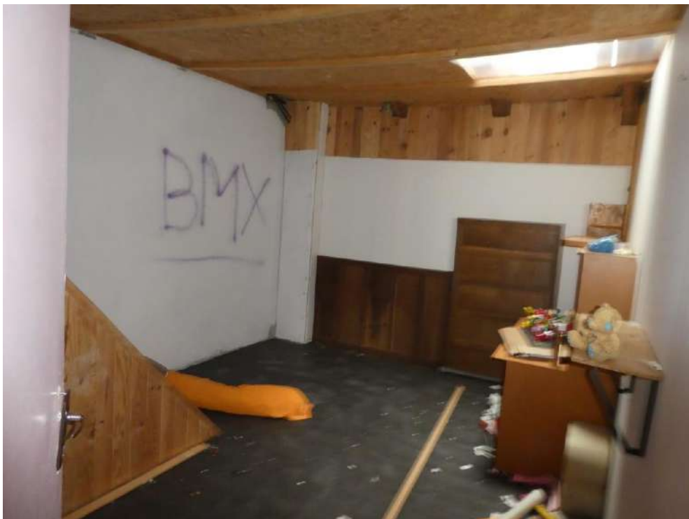
Chambre en cours de réalisation
