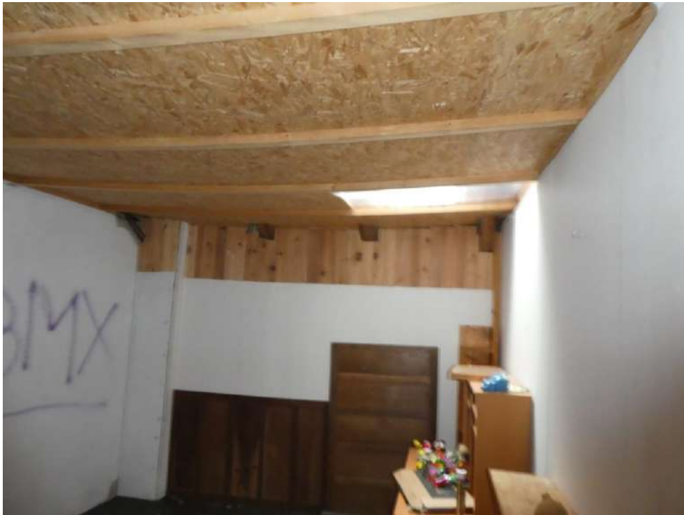
Chambre en cours de réalisation
