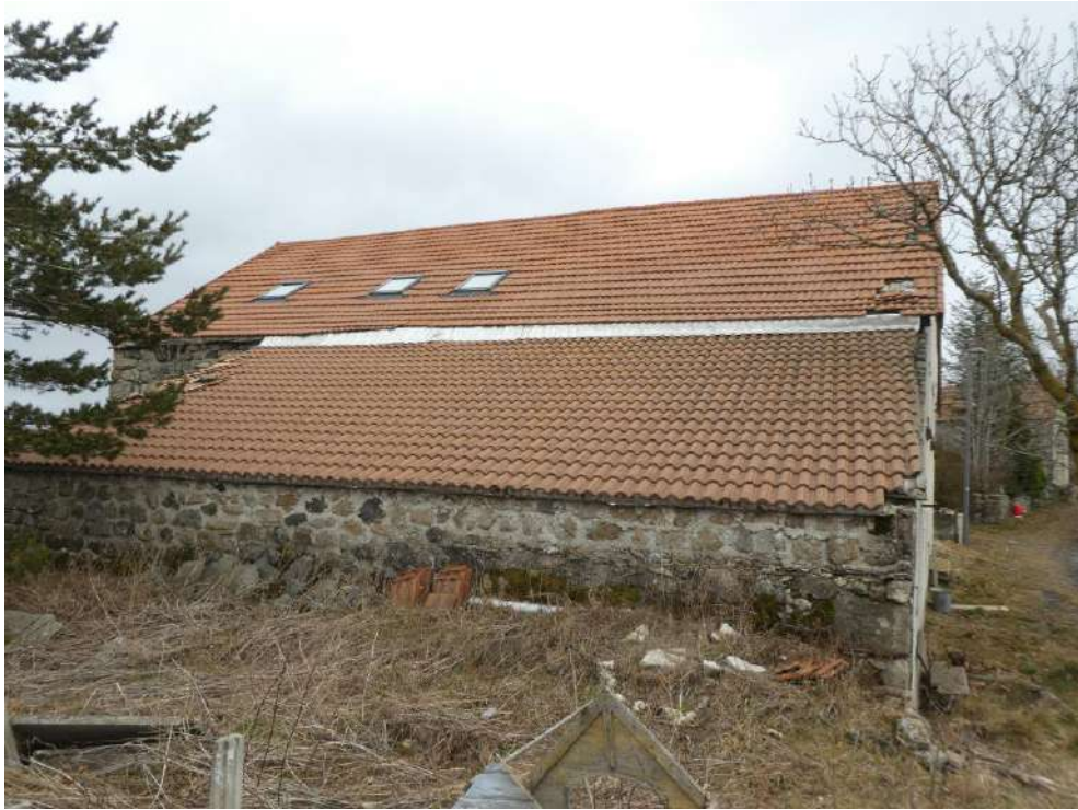
Toitures de la maison et de l'addition
