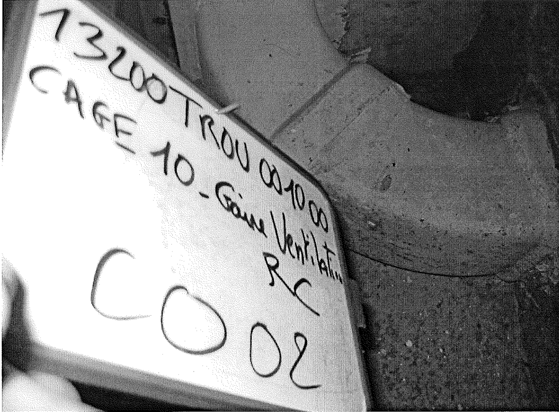
Conduit fibro-ciment n° 2 Bâtiment 10 Gaine ventilation au RDC
