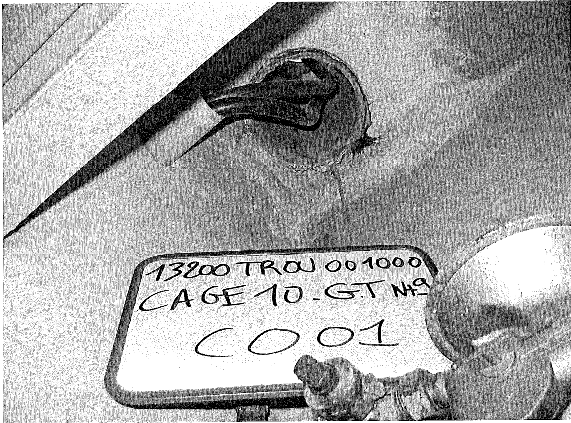
Conduit fibro-ciment n° 1 Bâtiment 10 Gains techniques au niveau 9
