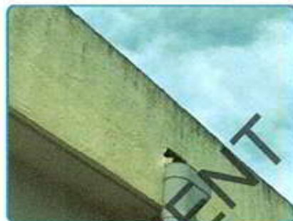
D.O. n° 1 sur Conduit(s) de fluide(s) en fibre ciment
