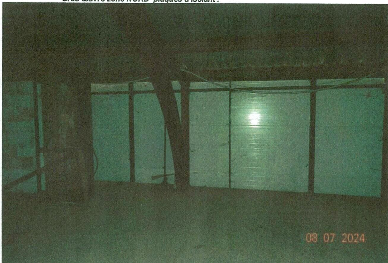
Gros œuvre zone NORD plaques d'isolant .
