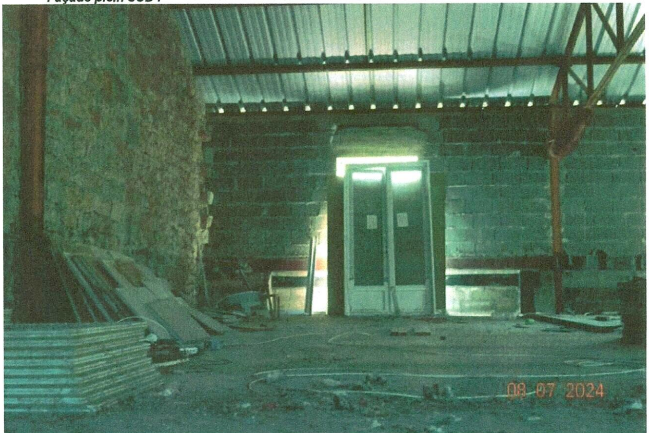
Façade plein SUD .
